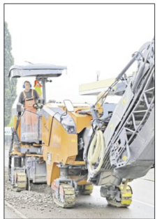
Mitte März wird in der Alldorfer Ortsmitte weiter gearbeitet. Foto: Habermann
